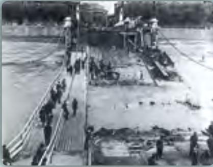
Le pont de l'Université dont la travée centrale a été détruite lors du départ des troupes allemandes le 2 septembre 1944 et une des cinq passerelles piétonnes en bois posées sur ce qu'il restait de l'accès original à l'Université. B. Magnillat-Rapp (2004)
